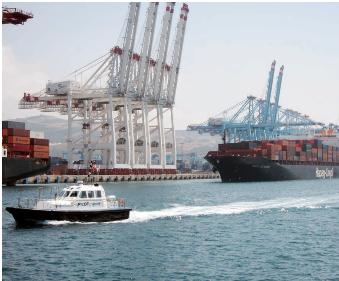
L'un des principaux projets lancés dans la période 2019-2021 en matière de renforcement des infrastructures porte sur l'extension de la digue de protection Moulay Youssef au niveau du port de Casablanca, avec un budget de plus de 1,1 milliard de DH (Ph. L'Economiste)
