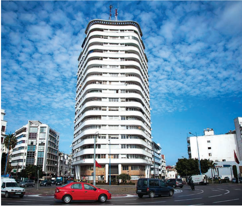
Dès les années 1920, le monde va scruter, l'essor spectaculaire de la ville, dont le champ d'exercice fera école dans les langages de la modernité architecturale. L'immeuble Liberté premier gratte-ciel du continent sera construit entre 1949 et 1951. Il fut l'un des premiers bâtiments à intégrer des solutions écologiques. (Ph. DR)
